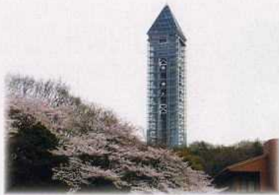
東山スカイタワー。 市制100周年を記念して1989年に完成した東山のシンボル。展望室は高さ100mで、車いすでも入場可能です。
